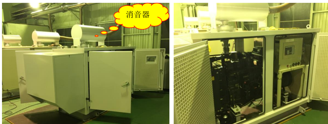
图 3-17 排气消声器布置位置
