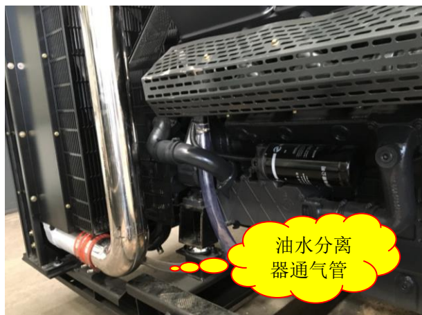
图 3-31 油气分离器通气管安装示意图
